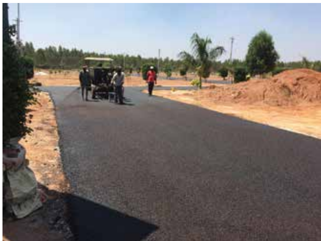
Kolnička konstrukcija s recikliranom plastikom (Indija)
